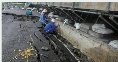
台風被害の復旧工事
