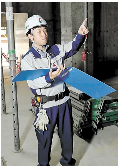
施工図通りに建設が進むよう職人に指示を出す松岡さん
